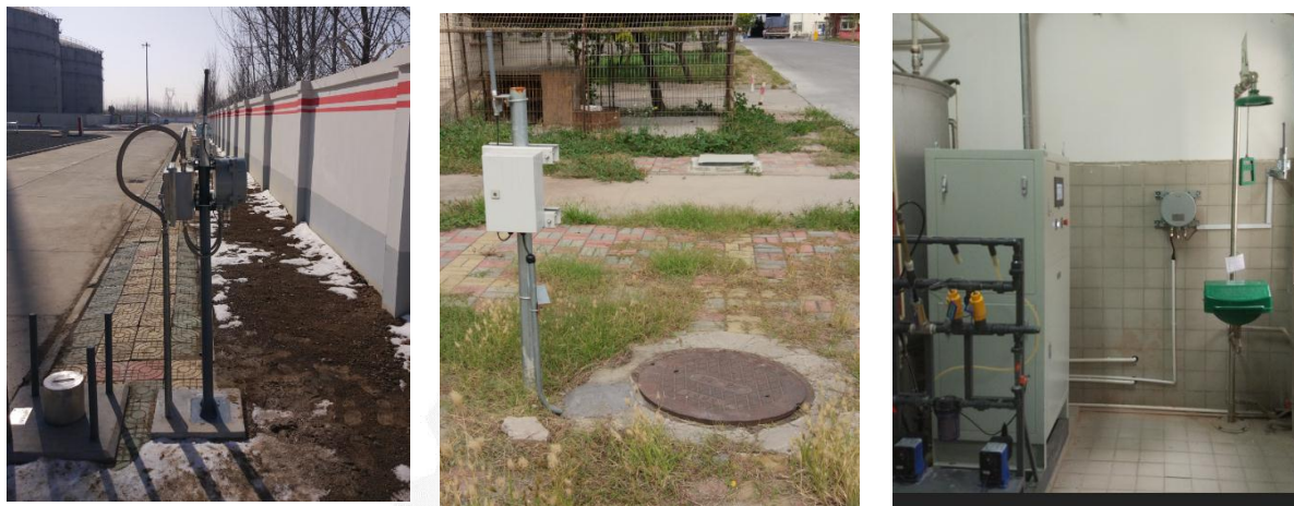
图 7 现场能源仪表数据采集设备安装照片
